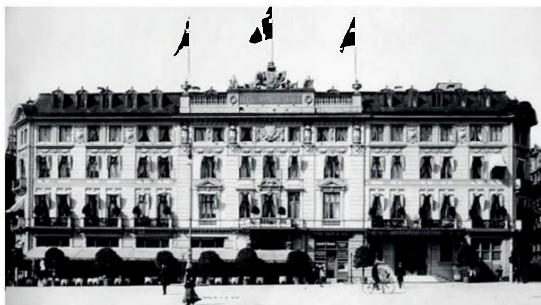
Hotel d'Angleterre efter renoveringen.
